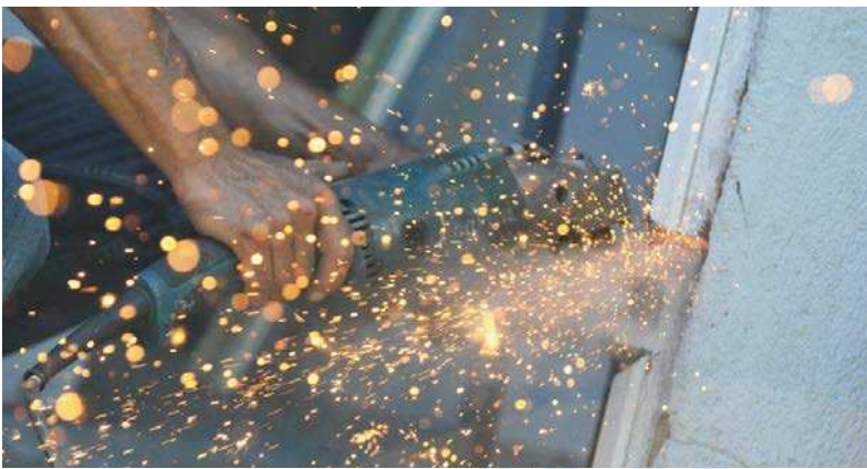
Роми работат на монтирање прозорци во Куманово
